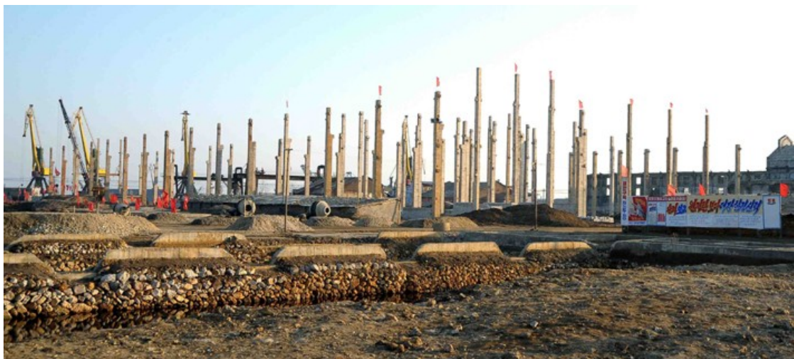
Zonas en construcción
